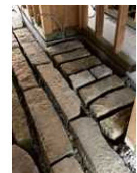
建物の中心を通る路地
