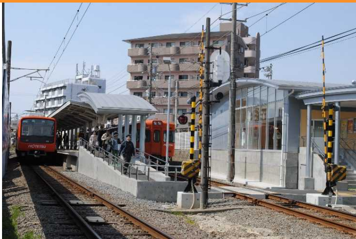
平成29年3月竣工の久米駅
