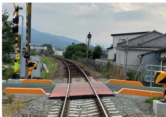
【徳島線 石井駅構内 石井東部踏切】
