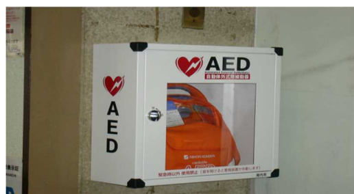
【駅構内に設置されているAED】
