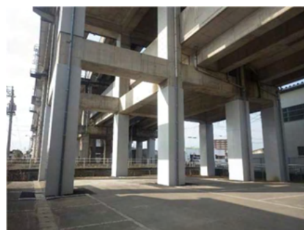
【高架柱の耐震補強】
