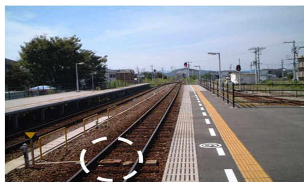
【ATS地上子の設置状況】
