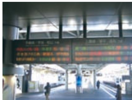
LED 乘车指示牌 LED表示による乗車案内板
