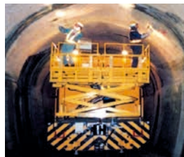
保守用車両を用いたトンネルの検査
