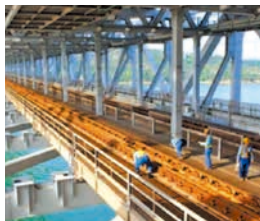
瀬戸大橋の定期検査
