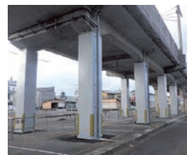
高架橋耐震補強
