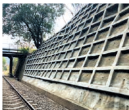
のり面防護工
