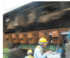
検査機器を用いた橋りょうの詳細な検査
