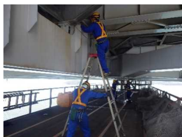
鉄道縦桁の検査
