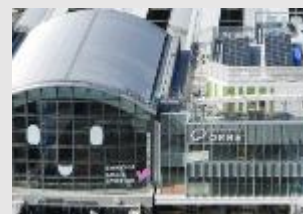
太陽光発電設備 (高松オルネ)
