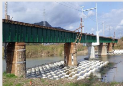
橋りょうの洗堀対策
