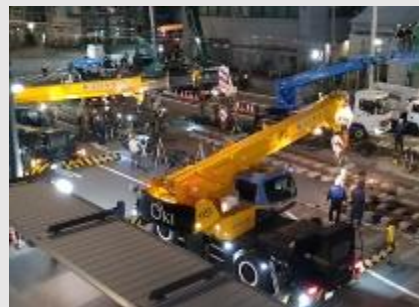
伊予鉄道花園線軌道移設工事
