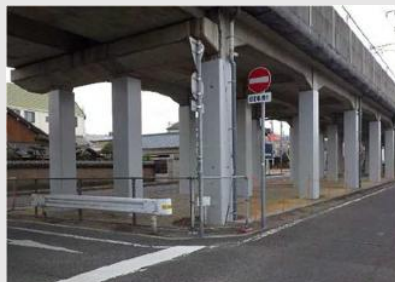
高架橋の耐震補強
