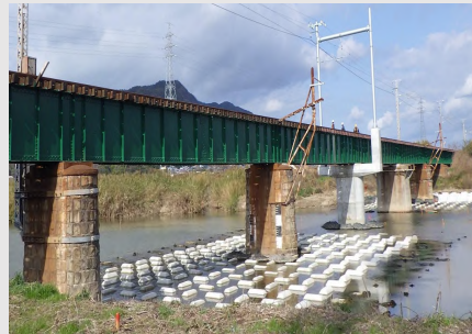
橋りょうの洗掘対策
