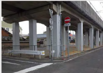
高架橋の耐震補強
