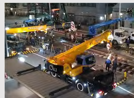
伊予鉄道花園線軌道移設工事
