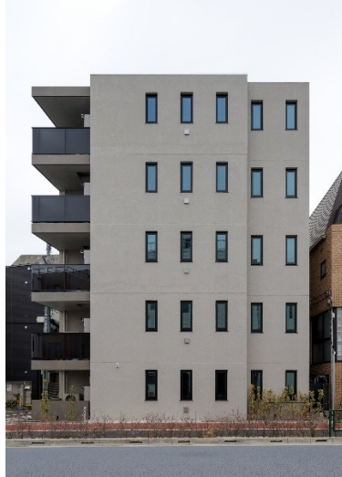
<外観(西面より)>
