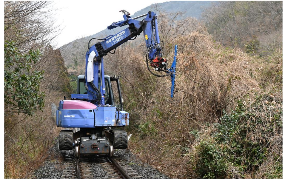
バックホウによる沿線樹木伐採
