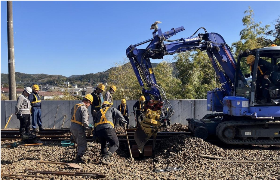
バックホウによるマクラギ交換
