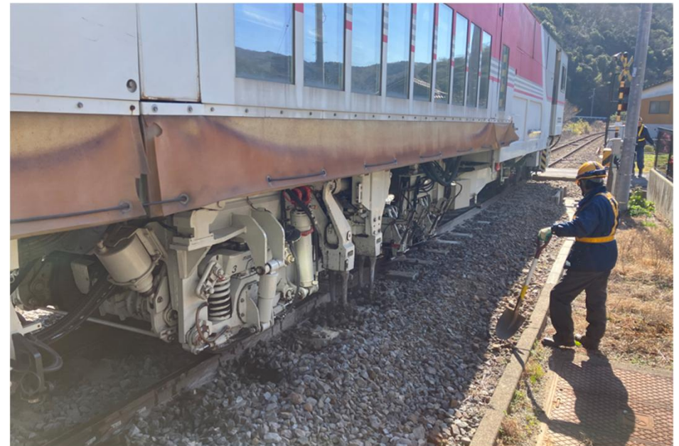
大型保線機械による軌道整備
