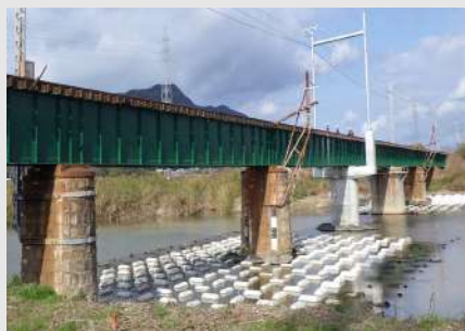
橋りょうの洗掘対策
