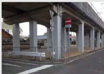
高架橋の耐震補強
