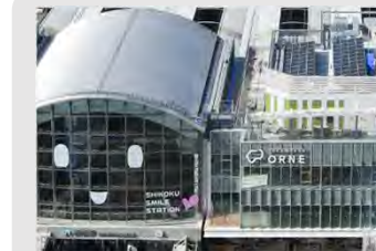
太陽光発電設備 (高松オルネ)
