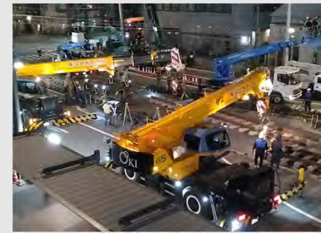
伊予鉄道花園線軌道移設工事
