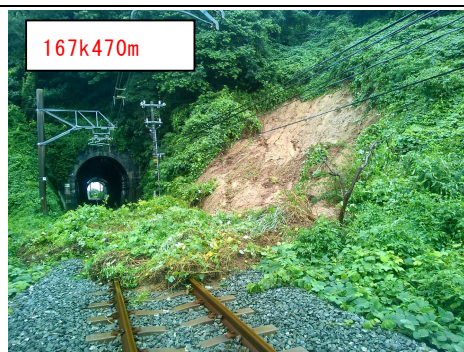
② 予讃線菊間・浅海 167k470m、168k040m 斜面崩壊
