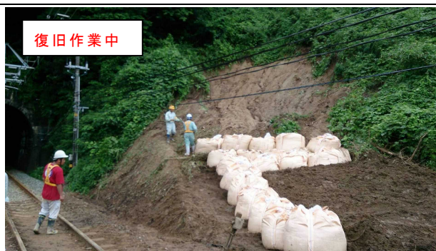
② 予讃線菊間・浅海 167k470m、168k040m 斜面崩壊
