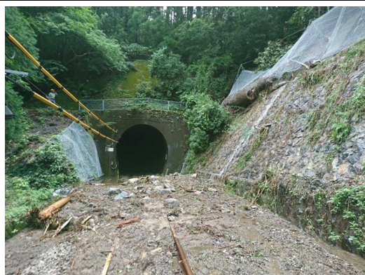
⑥ 土讃線繁藤・新改 100k500m 斜面崩壊
